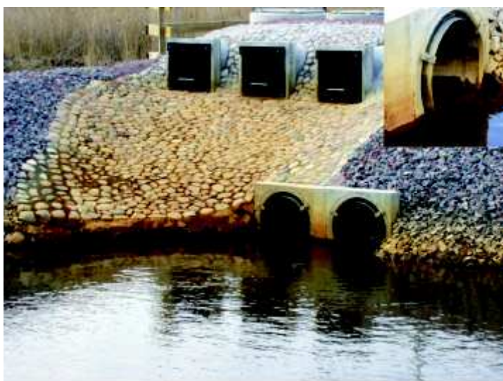
WaStop Ø 600 instalovaný pro spolehlivé zamezení zpětného toku.
